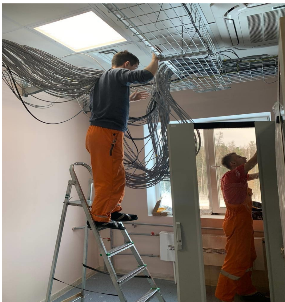
Рисунок 3.1 – Монтаж СКС
